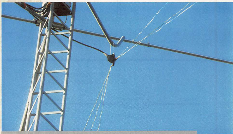
Fixation du multi-dipôle sur un mât.
