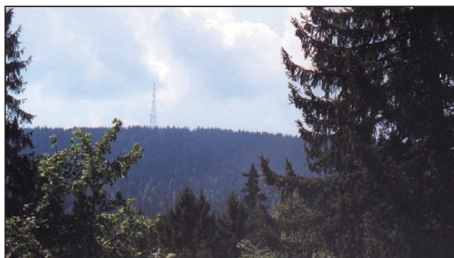
L'émetteur de la Barilette vu depuis la Givrine.
